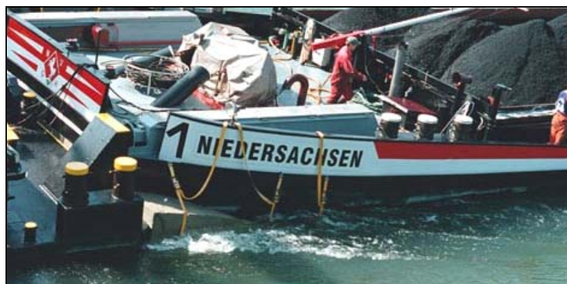
Abb. 1: Auffüllen der Koppelstelle mit Verdrängungskörpern
